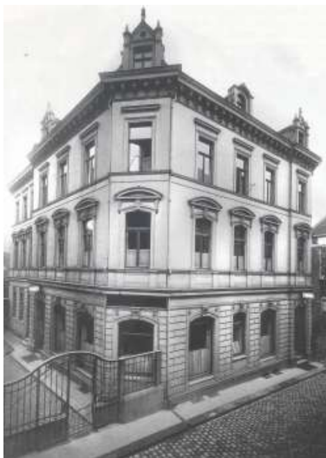
Fot. 1. Budynek Stadtbibliothek Essen, 1906.
